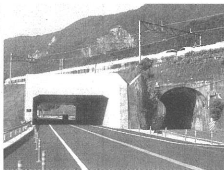
福井県内に新設された線路下アンダーパストネル
